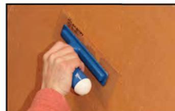
Étape 4 - à mi séchage, resserer l'enduit à l'aide d'une spatule plastique souple.
