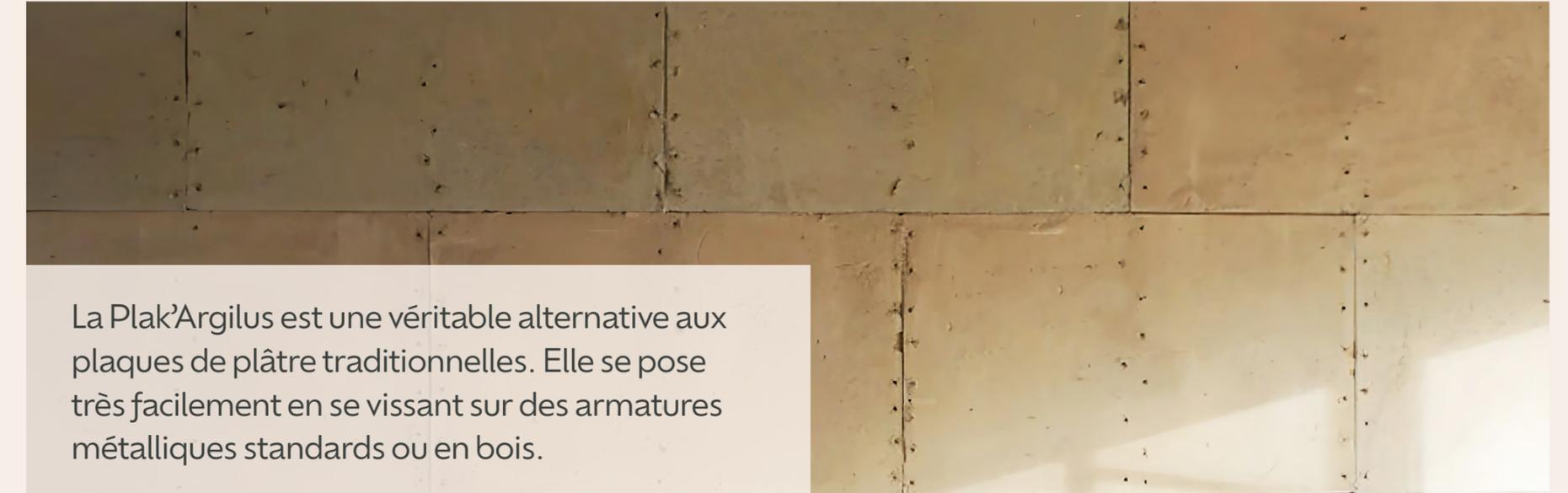
La Plak'Argilus est une véritable alternative aux plaques de plâtre traditionnelles. Elle se pose très facilement en se vissant sur des armatures métalliques standards ou en bois.
