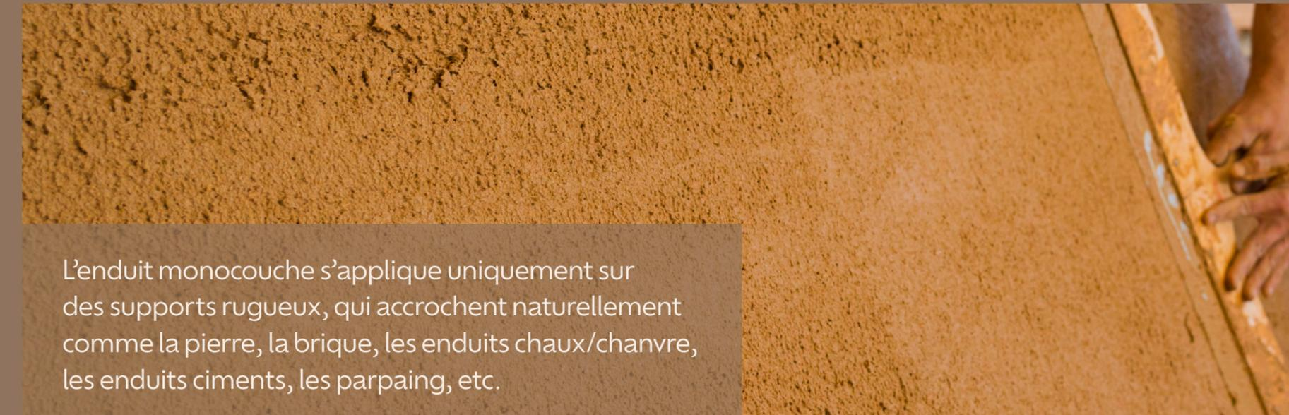
L'enduit monocouche s'applique uniquement sur des supports rugueux, qui accrochent naturellement comme la pierre, la brique, les enduits chaux/chanvre, les enduits ciments, les parpaing, etc.
